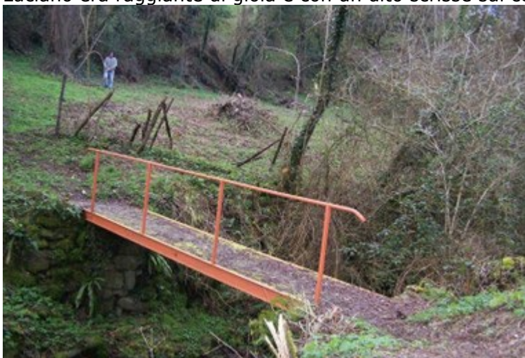
Il ponte di Luciano
