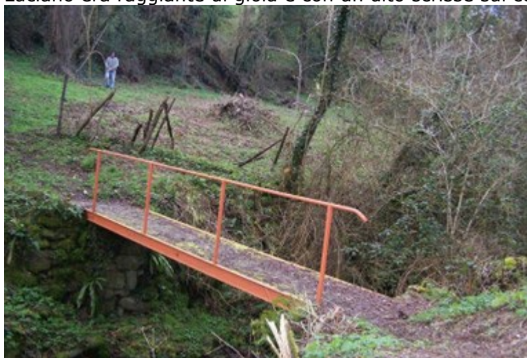
Il ponte di Luciano
