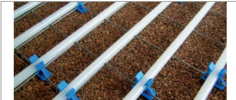
Posa delle tubazioni sull'isolamento e fissaggio mediante clips
