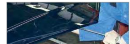
Figura 4: Raddrizzamento di un cofano con leva all'interno
