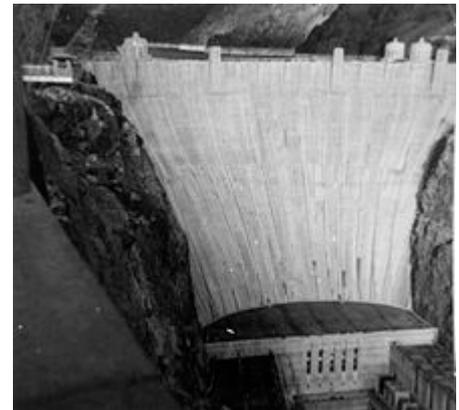
Figura 30: Diga ad arco utilizzata per produrre energia elettrica
