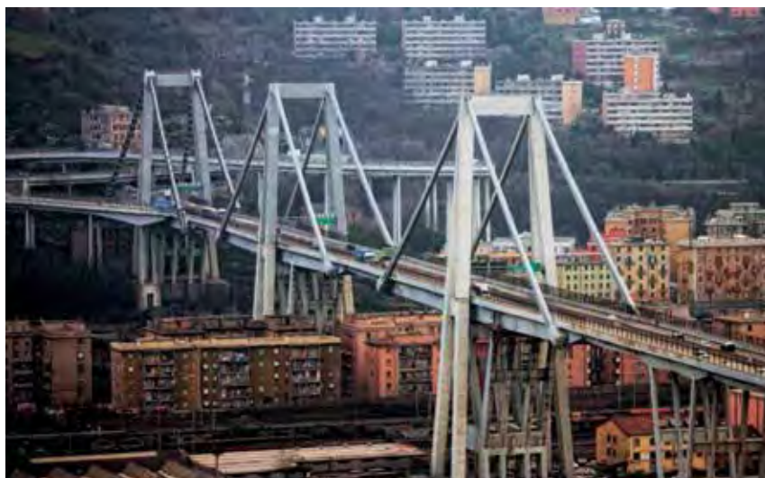
Il ponte Morandi di Genova prima del crollo
